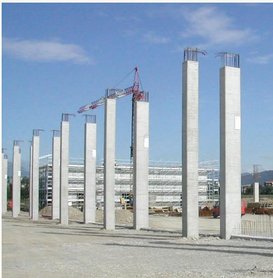
Le strutture in cemento armato che formano l'ossatura della Fiera.
